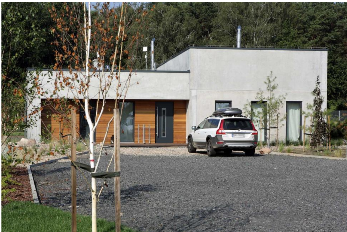
Beton na fasadzie, powierzchnia gładka od formy stalowej, fot. Baumat
