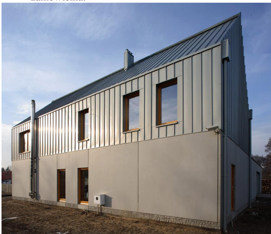
Ściany betonowe lazurowane farbą keim, fot. Baumat
