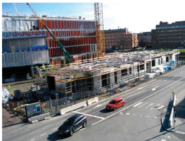
Fot. 6. Widok na plac budowy od strony północnej
